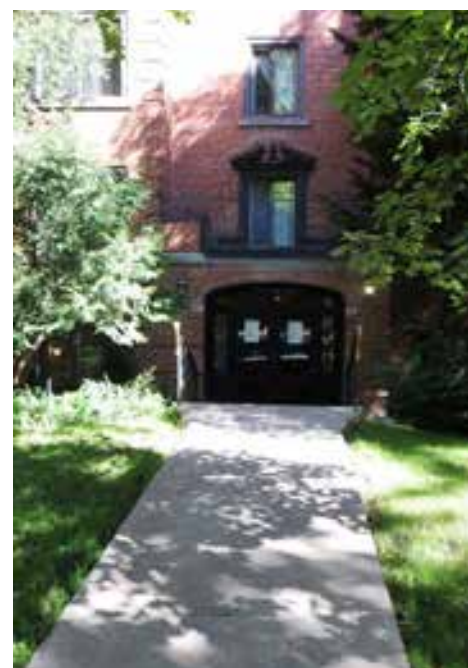
EXEMPLE DE TROTTOIR DE BÉTON (VOISIN EST)
